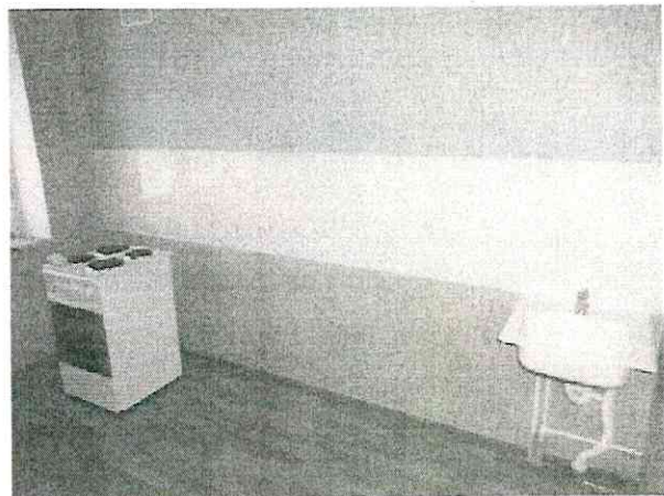
Отделка помещения кухни
